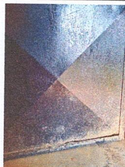
FOTO 6. Las puertas se encuentran óxidadas, motivo por el cual impide abrir y cerrar de manera adecuada.
